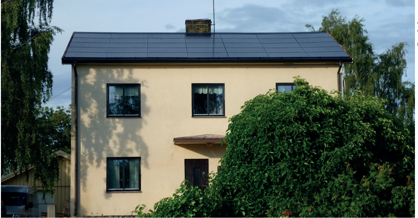
En solcellsanläggning som täcker hela taket ger ett snyggt helhetsintryck.
